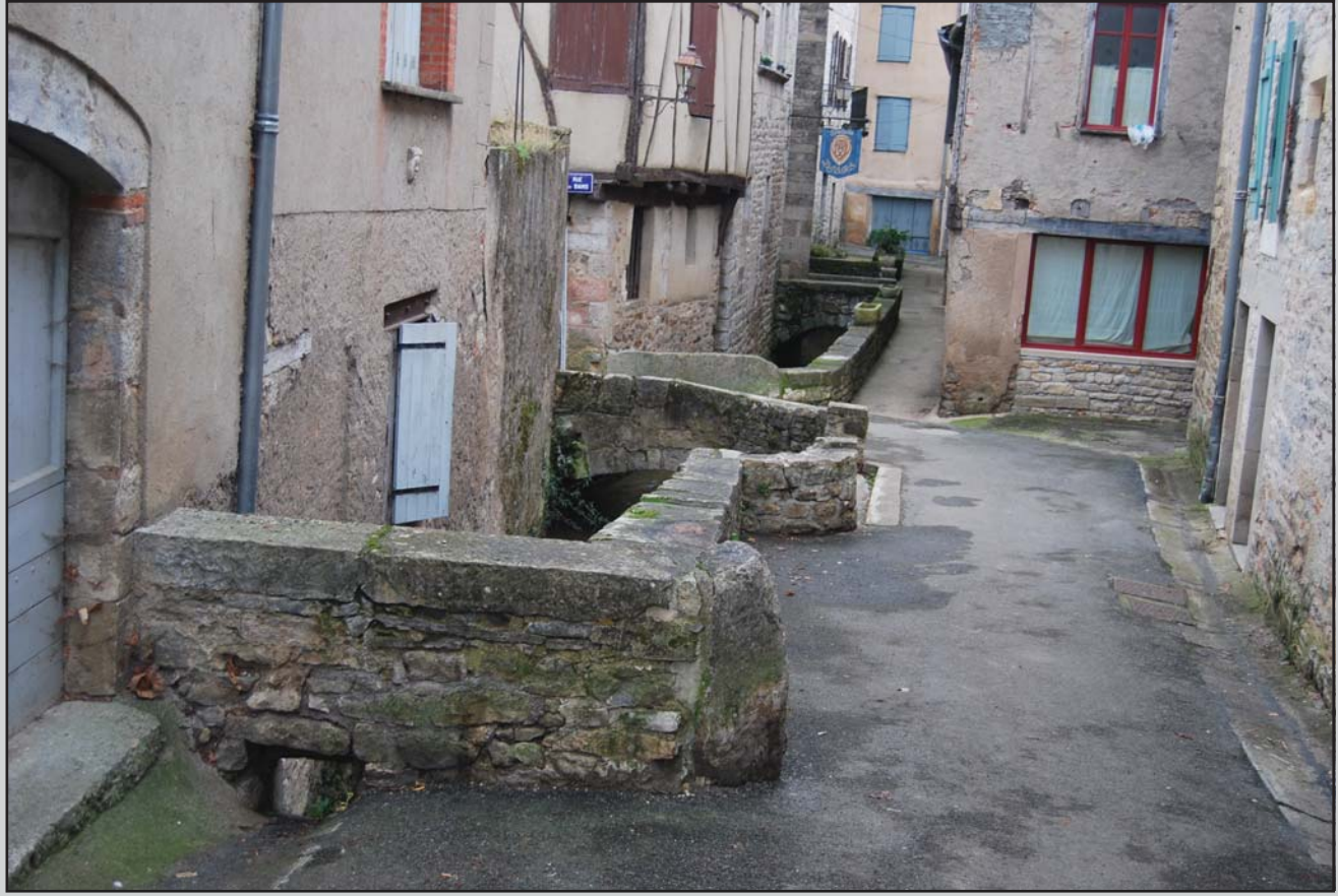
Canal de la rue Rive-Valat vu depuis le nord
