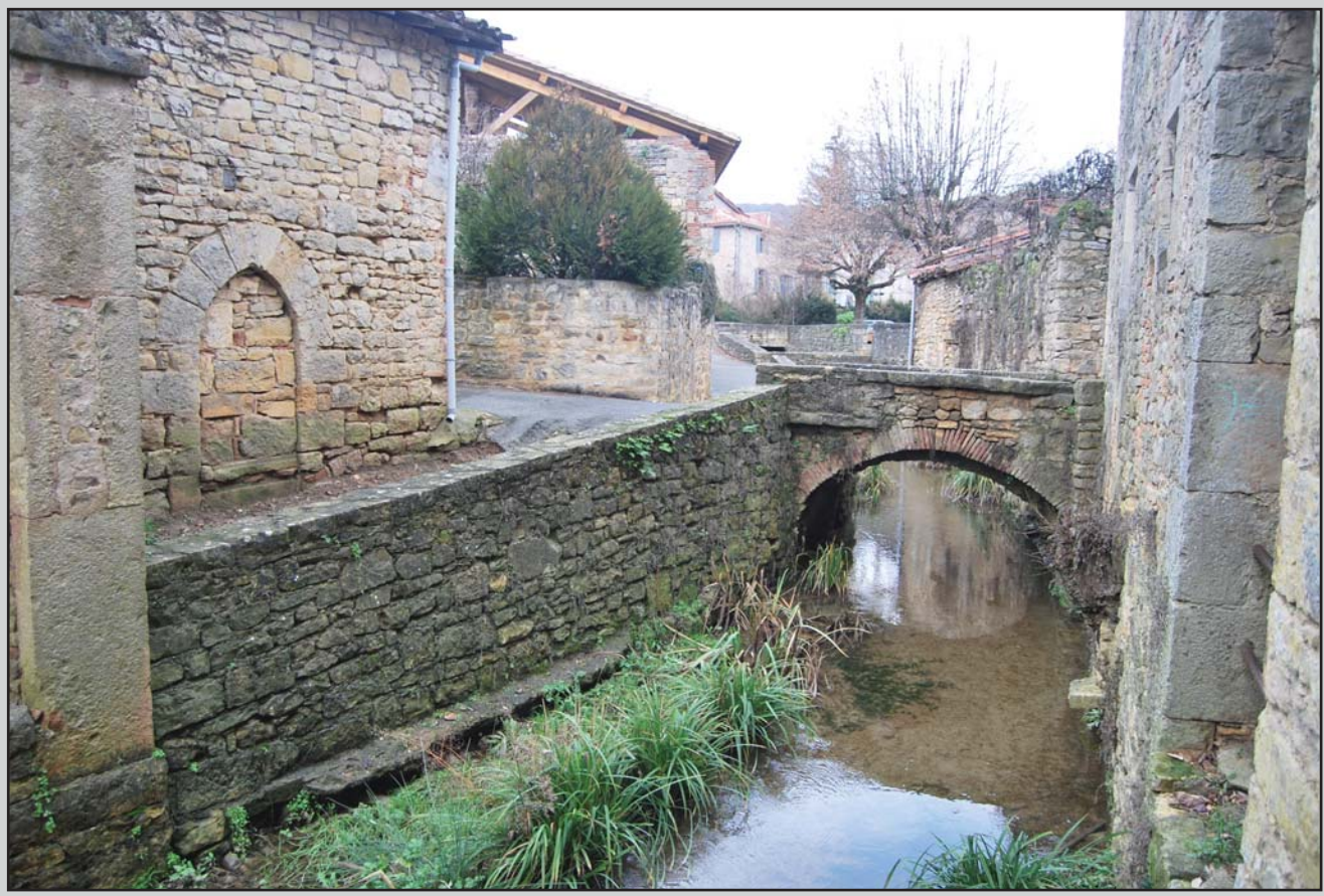
Canal du Bessarel vu depuis la rue Delphinat
