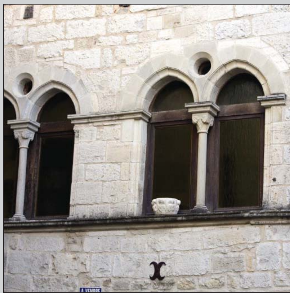
Détail des baies géminées du premier niveau
